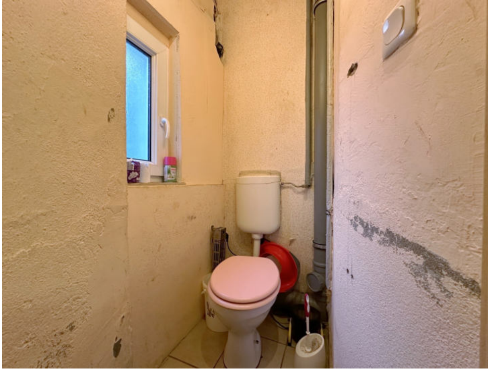
WC im Erdgeschoss
