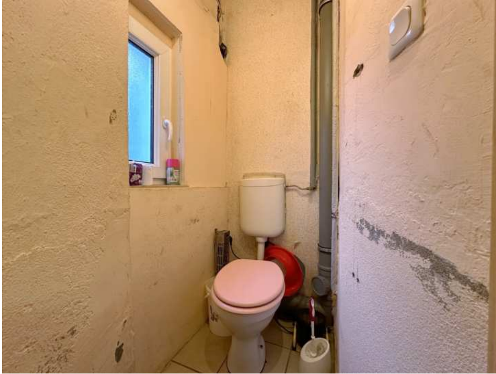
WC im Erdgeschoss
