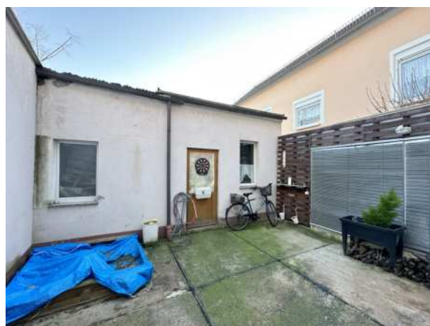
Anbau im Innehof
