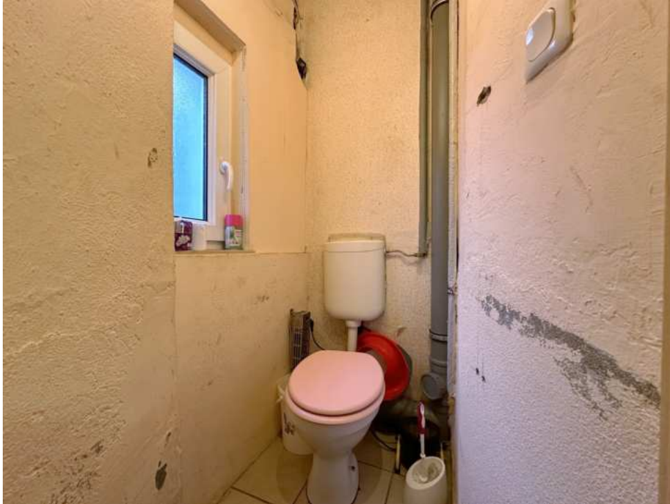
WC im Erdgeschoss
