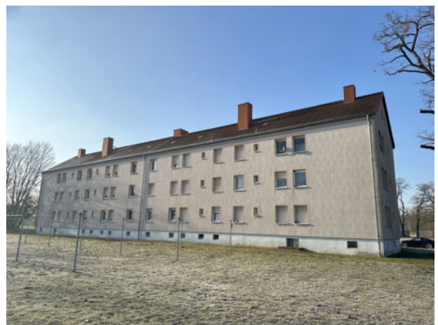
Hausrückseite mit Wäscheplatz
