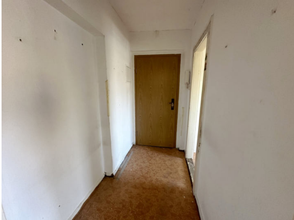
Beispiel Flur unsaniert
