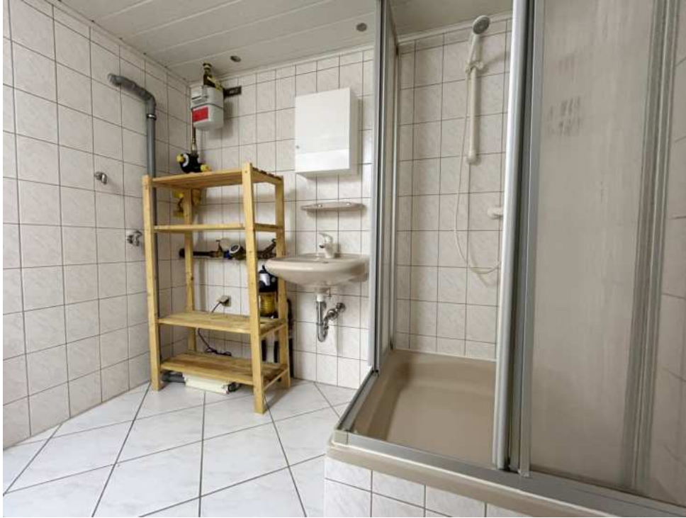
Waschraum im Keller
