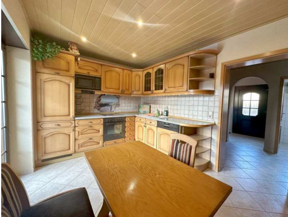
Fußbodenheizung in der Küche
