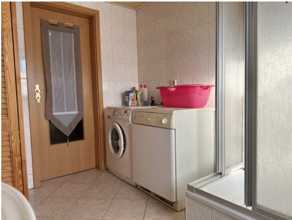
Waschmaschinenanschluss im Badezimmer
