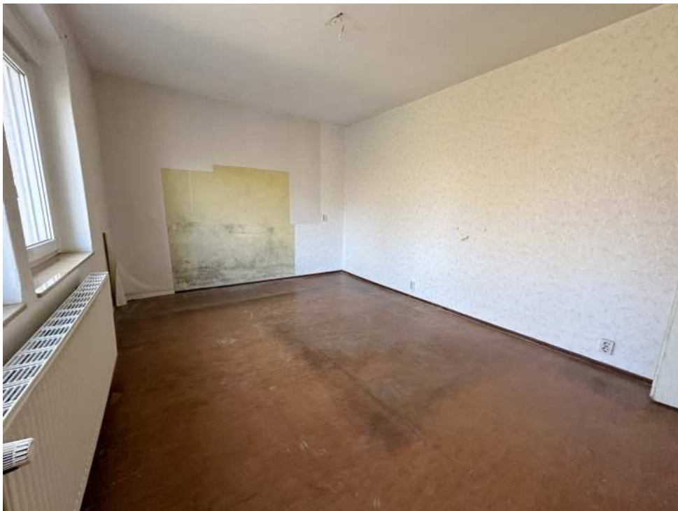
Beispiel Schlafzimmer unsaniert
