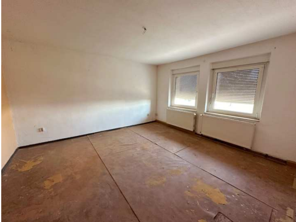
Beispiel Wohn- und Schlafzimmer 1-Raum-Wohnung unsaniert
