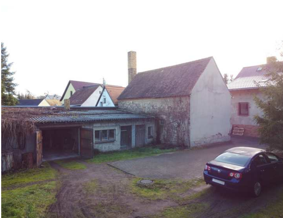
Garagen und Nebengebäude
