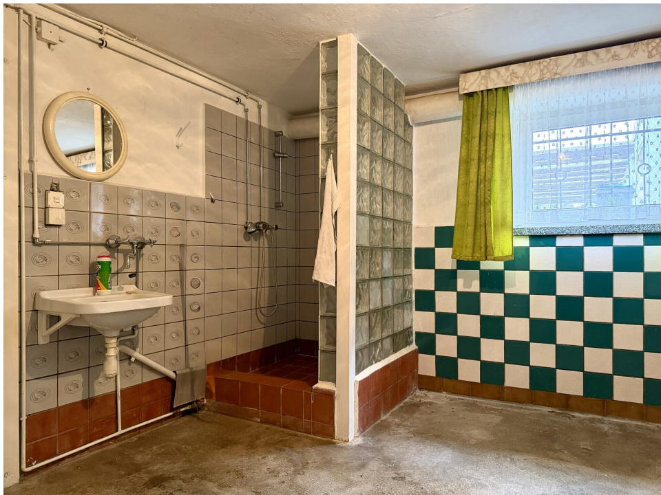
Waschraum im Keller
