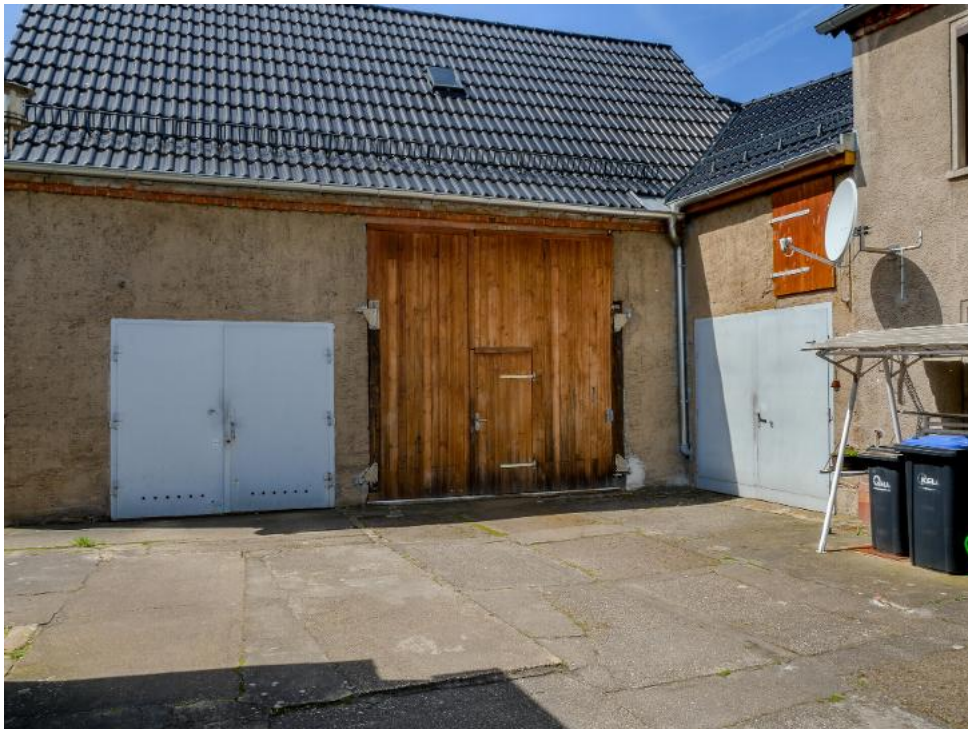
Scheune und Garagen
